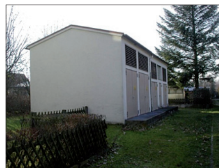
Obr. 9a. Rozvodna před renovací
