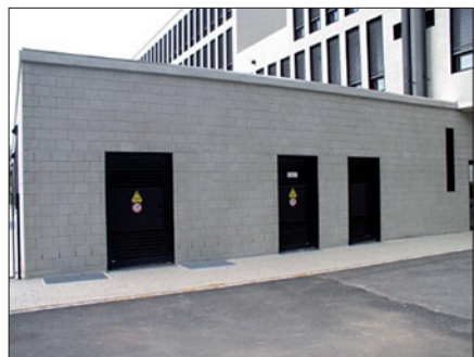
Obr. 1. Příklad integrace transformátorové stanice do zástavby
