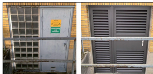
Obr. 7. Projekt renovace dveří, povrchová úprava speciální barvou DB 703, vzhled před renovací a po ní
