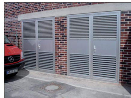
Obr. 3. Novostavba stanice v průmyslovém prostředí, dvoukřídlé dveře s větracími prvky
