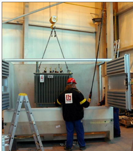
Obr. 11. Instalace transformátoru do stanice
