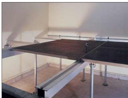
Obr. 10. Detail mezipodlahy pro montáž technologie
