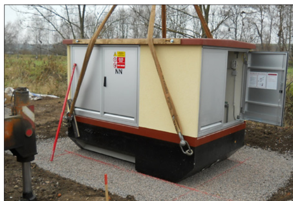
Obr. 12. Instalace transformační stanice na místě stavby
