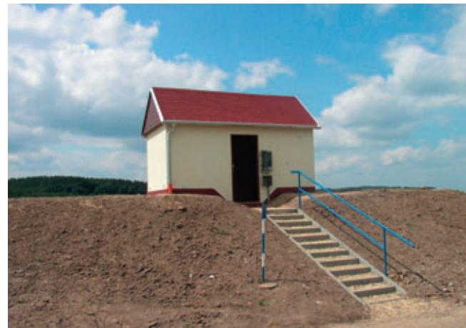
a nadzemním obslužným objektem. Každá komora je opatřena stěrkou s atestem pro styk s pitnou vodou, vodotěsnými poklopy a je zabezpečena proti průniku podzemní vody do komory vodojemu. Obslužný objekt je vybaven elektroinstalací, automatickým ovládáním vodojemu, tepelnou izolací, temperováním, libovolnou střechou apod.
