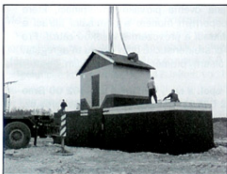
Obr. 1a Montáž dvoukomorového vodojemu Buk u Prachatic
