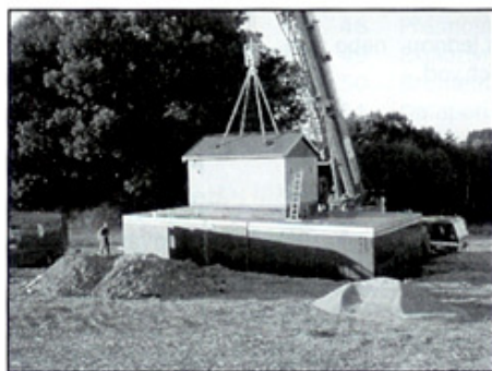
Obr. 1b. Montáž čtyřkomorového vodojemu Jankov
