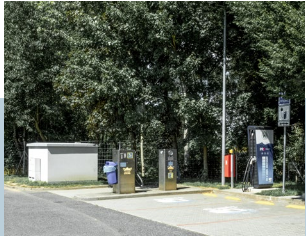
ČERPACÍ STANICE CHRATAVA
