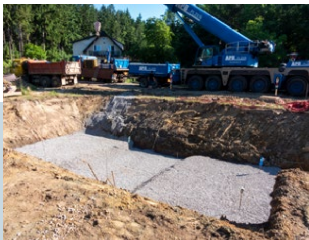
1. Připravený podkladu – zhutnělé štěrkové lože
