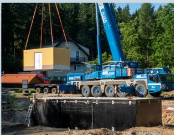
9. Montáž technologického domku
