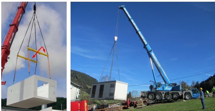
Obr. 19: Montáž se střechou a bez střechy
