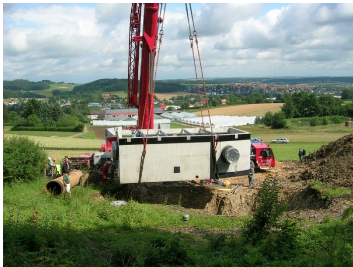
Obr. 23: Zdvihání betonové buňky pomocí textilních pásů
