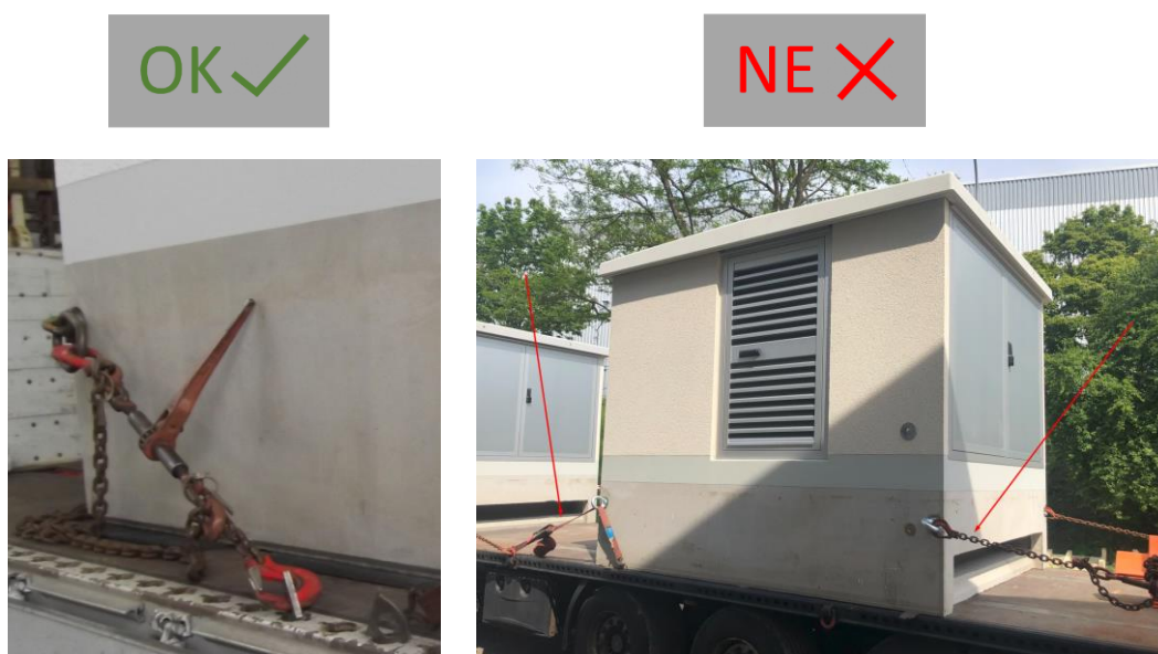
Obr. 10: Vázací body na vnějším lící podélných stěn
