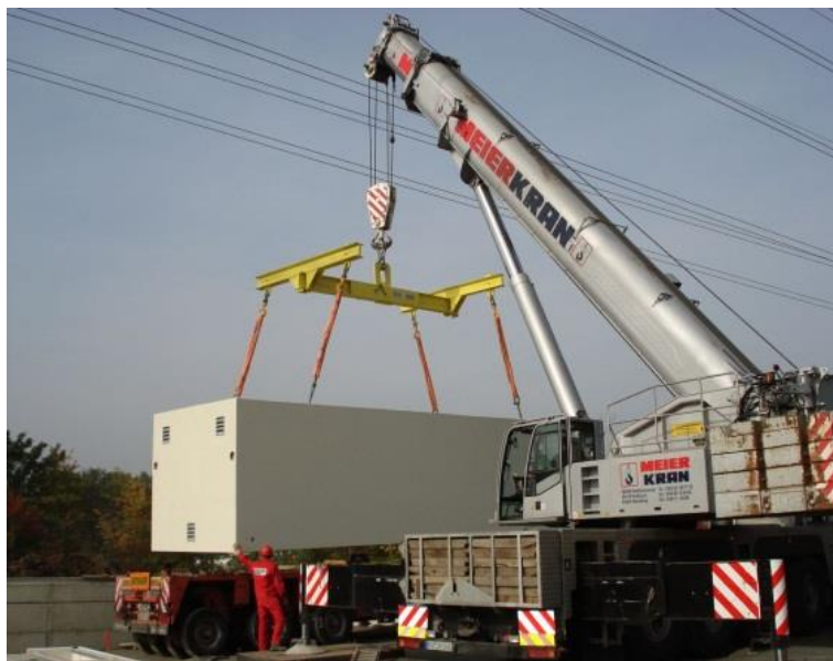
Obr. 28 Nosná traverza (H-traverza)
