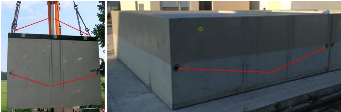
Obr. 7: Kotvy pro zdvihání a zajištění nákladu zvlášť (vlevo) a kombinované (vpravo)
