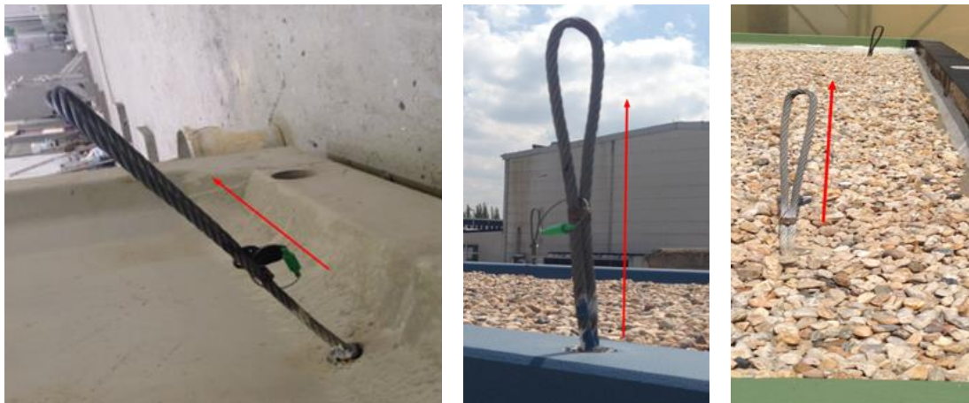
Obr. 24 Příklady dovoleného směru tahu
