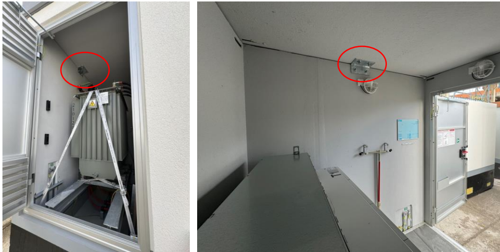
Obr. 22: Úhelníky pro zajištění během přepravy
