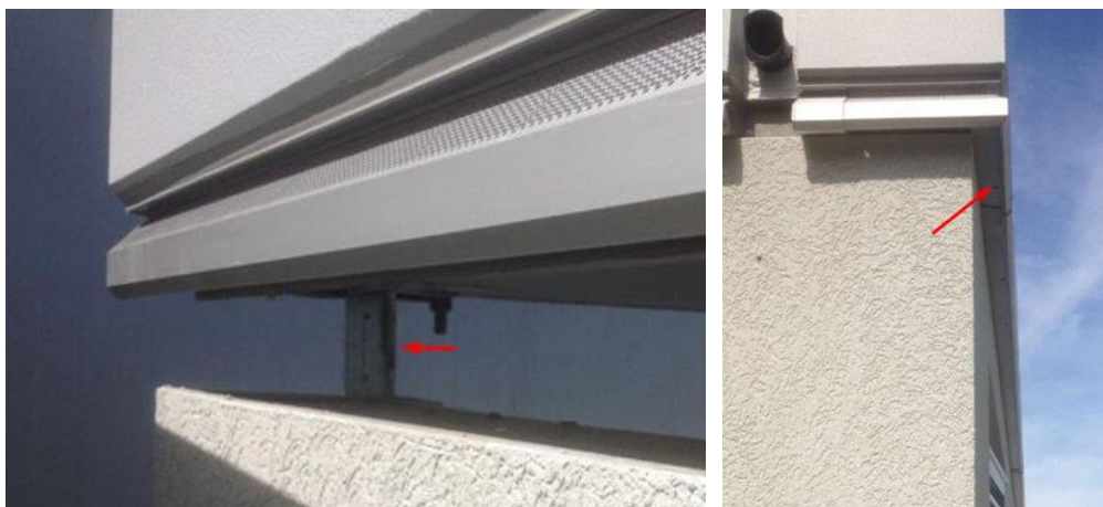
Obr. 26 Převážní úhelníky (vlevo) a klempířské prvky (vpravo)
