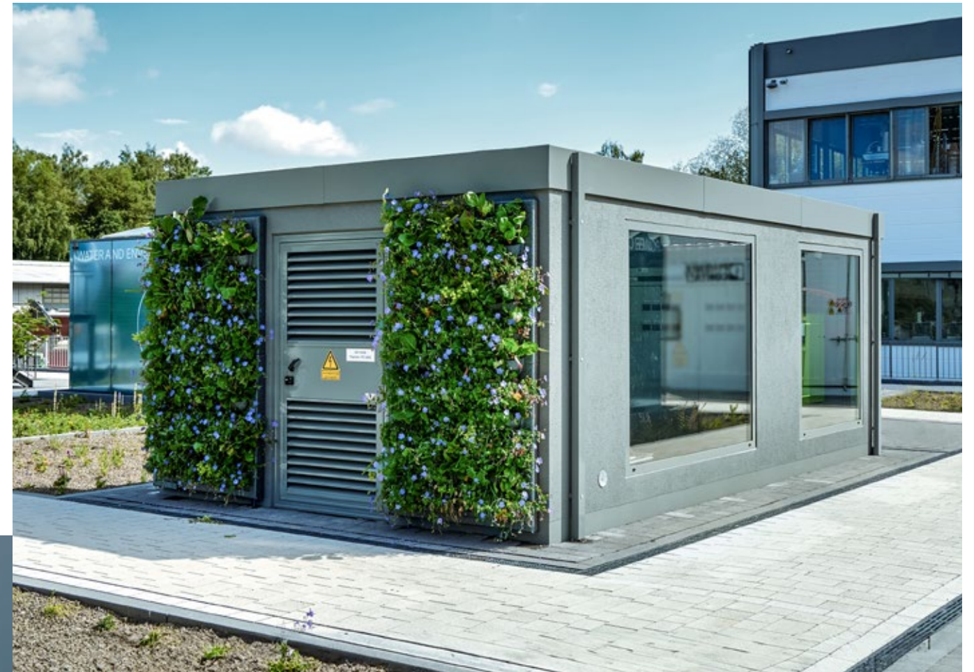
Die erste Trafostation aus Carbonbeton.
