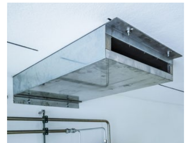
Schallgedämmter Blechkanal
