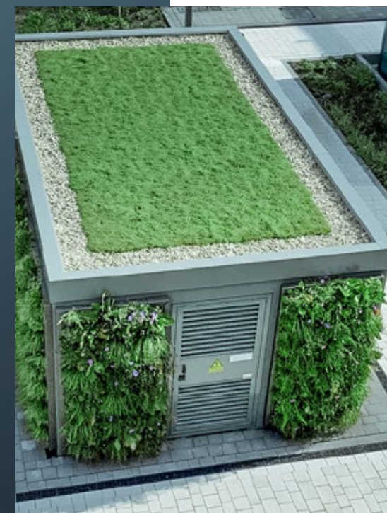
Die erste Trafostation aus Carbonbeton.
