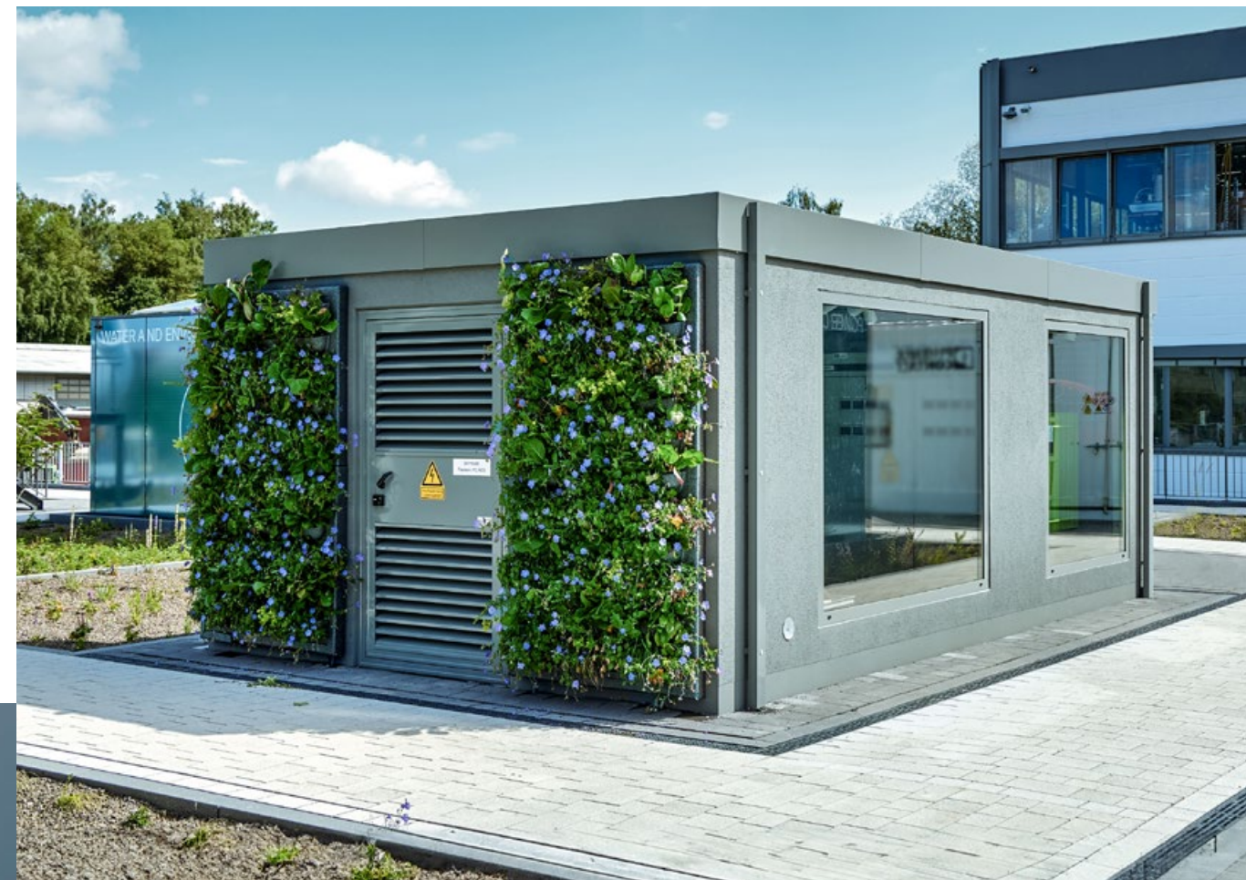
Die erste Trafostation aus Carbonbeton.
